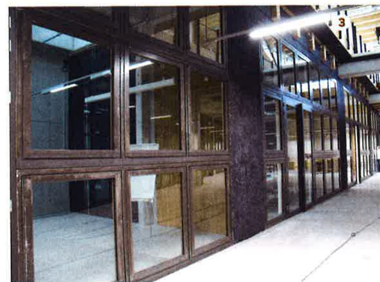
1 // De oostgevel, grenzend aan een tuin van het hoofdkantoor van de bank, is uitgevoerd als groengevel. 2 // De westgevel heeft een overstek. Langs de gevel is beloopbaar glas aangebracht waarmee licht binnenkomt in de kelder. 3 // De puien in de kelder zijn gemaakt van gestapelde oude kozijnen. De donkere stroken daartussen zijn voorzien van textielstuc.
